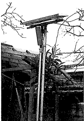
桜井さんの自宅に設置された 太陽光パネル
